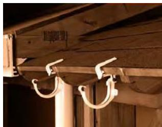
Фиксирайте скобите върху последната столица. Регулиращият елемент спомага за по-добро закрепване в зависимост от дебелината на столицата.
