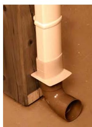
Универсалния крайник позволява свързването на водосточната тръба Триумф с цилиндричната отводнителна система.
